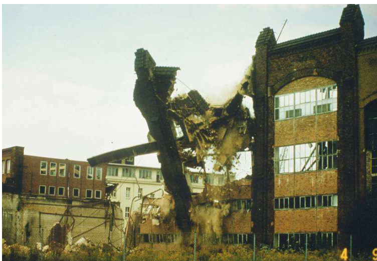
2 Abriss einer Henschelhalle, um 1970
