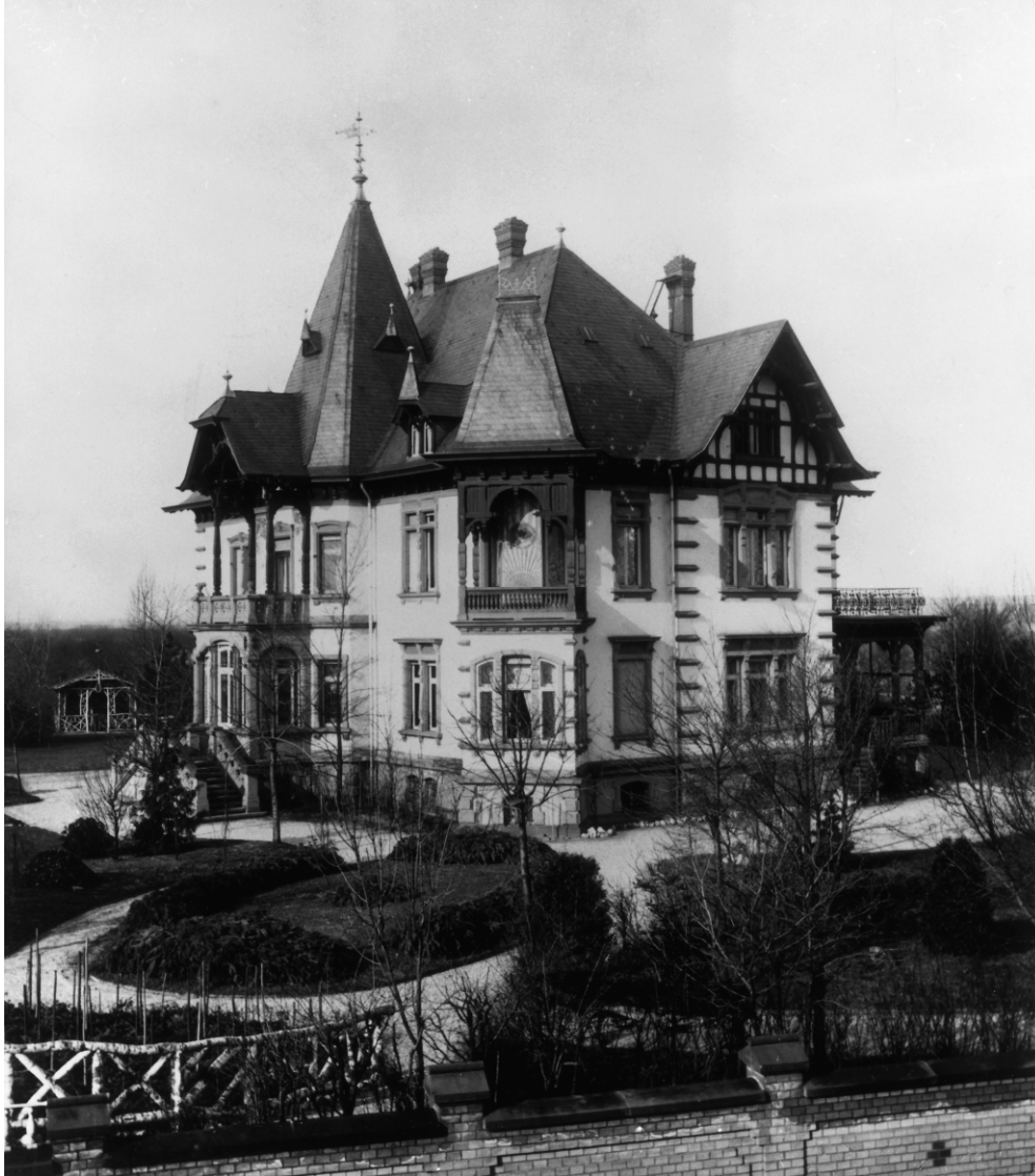
6 Villa Sophienheim, erbaut 1894
