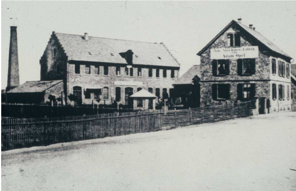
4 Wohnhaus und erster Fabrikbau Adam Opels, 1868
