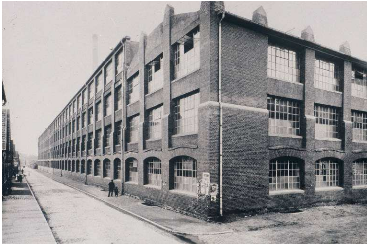
9 Fabrikbau entlang der Weisenauer Strasse, erbaut 1907-17
